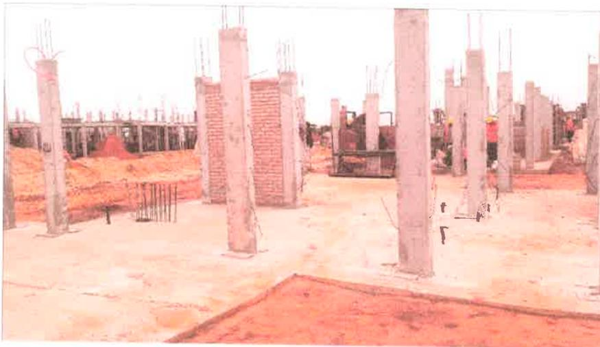
En esta fotografía podemos observar, otro de los módulos con platea y columnas de hormigón armado construidos y mamposterías en construcción
