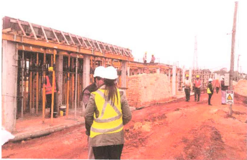
En esta fotografía podemos observar uno de los módulos con platea y columnas de hormigón armado construidos; el encofrado para construcción de losa de hormigón armado, acopio de materiales de construcción y el personal en obra con su equipamiento de seguridad correspondiente.
