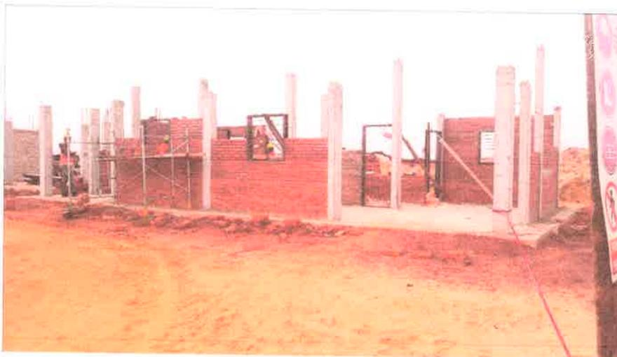
Observamos algunas de las mamposterías de elevación en construcción y la colocación de parte de las aberturas.
