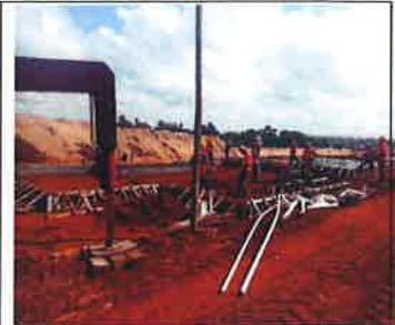
**Foto 06.** Manzanas en las que se está iniciando el proceso de encofrado de losas, la fck (resistencia característica) del hormigón es 210 kg/cm<sup>2</sup>
