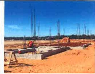
**Foto 15.** Se observa construcción del Centro Comunitario, fundación con zapatas y vigas cadena de fundación.
