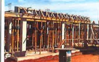
**Foto 03.** Encofrado para la losa superior de piso, en los pilares se han dejado los arranques para las paredes.
