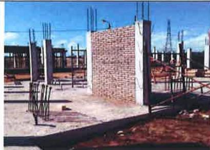
**Foto 04.** Se está empezando a construir la mampostería. Por los pilares se han dejado los arranques respectivos para encastrar pilares de hormigón y mampostería de ladrillo. Se utiliza una dosificación de mortero específica para la mezcla
