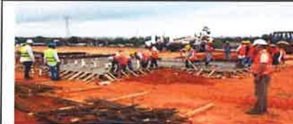
**Foto 7.** Colocación de la primera capa de hormigón de 10 cm., luego se procede a colocar la armadura de losa para finalizar con la siguiente capa de hormigón de 10cm., para así completar el espesor de platea requerido
