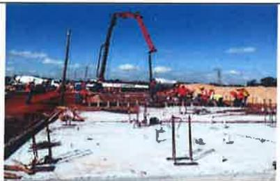
**Foto 01.** Jueves 17/05. Vista del camión de transporte de hormigón y la pluma de vertido de la mezcla. En primer plano se observa una losa cargada y endurecida y en segundo plano la losa preparada para recibir la carga de hormigón.
