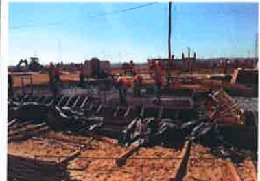
**Foto 06.** Vista de armadura superior e inferior de losa de fundación. Es una de las últimas losas a hormigonar.
