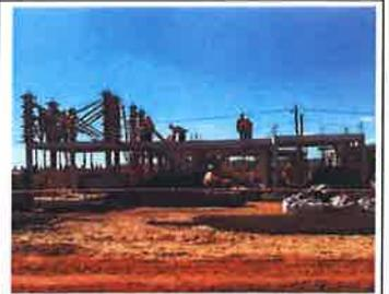
**Foto 09.** Vista de un módulo de dos viviendas de dos plantas, las escaleras de hormigón ya están finalizadas, faltan los pilares de un módulo, cerramientos verticales y techo
