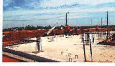
**Foto 02.** Se observa la losa de Hº Aº cargada y con los arranques para pilares
