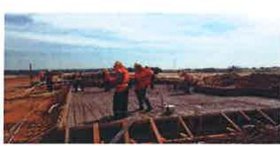
**Foto 01.** Continúa la construcción de casas, van avanzando por manzanas, se observa una losa de fundación con el hormigón pobre de base y las instalaciones sanitarias.
