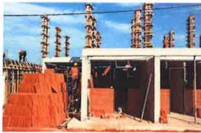
**Foto 04.** Se observan los caños flexibles color naranja de las instalaciones eléctricas. Acopio de tejas cerámicas.
