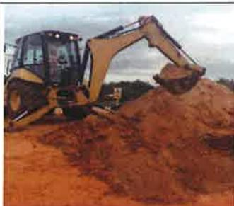
**Foto 05.** Trabajos de excavación a fin de construir los registros de desagüe cloacal del Reasentamiento.
