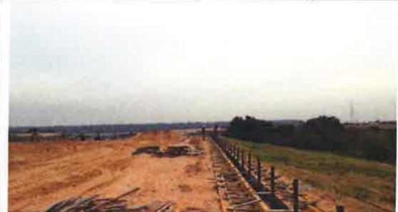
**Foto 03.** Construcción de vallado perimetral en zona talud este
