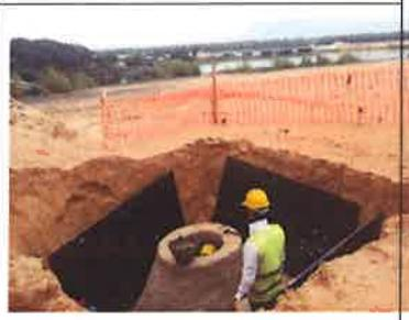
**Foto 06.** Un Registro de desagüe cloacal en etapa de terminación, luego se procederá a la excavación a fin de colocar los colectores principales de la red.
