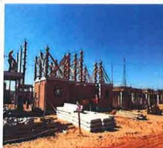
**Foto 02.** Vista de la terminación de cerramientos verticales cerámicos, así como viguetas de HoAo que serán usados como tirantería de los techos.
