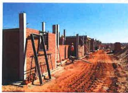
**Foto 01.** Colocación de aberturas metálicas
