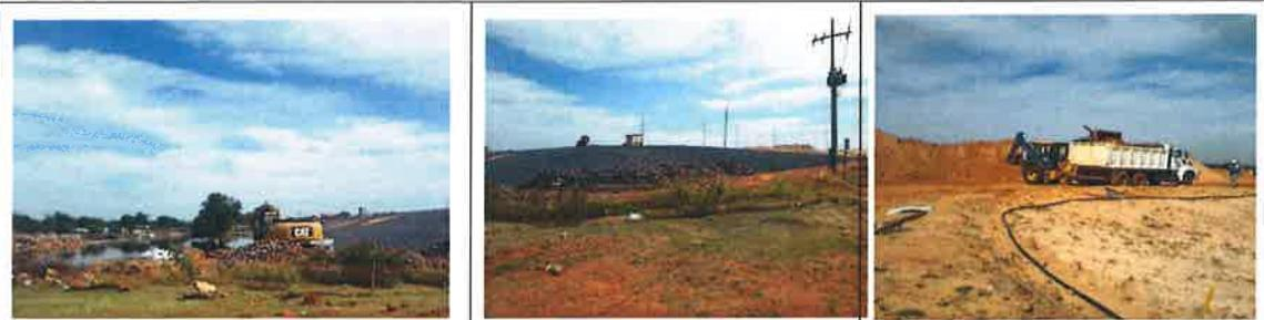
**Foto 01.** Obras de Relleno Hidráulico, talud de protección hacia el arroyo Mburicaó, finalizada, se observa el arroyo crecido y que momentáneamente inundó el camino de servicio
