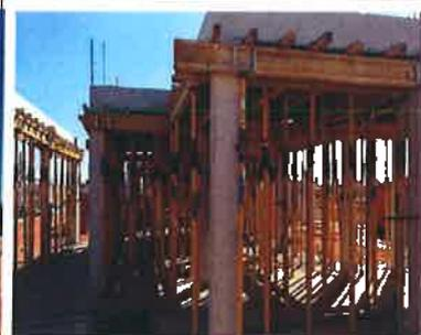
**Foto 03.** Se observan puntales de vigas y losa piso de vivienda de dos plantas.
