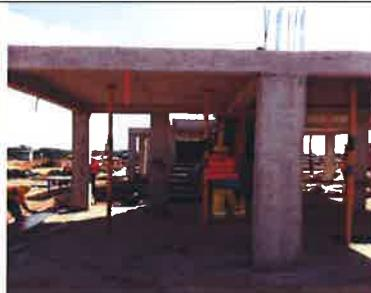
**Foto 05.** En los módulos donde se está finalizando la estructura de hormigón, se ha iniciado el encofrado de escalera, así como el vertido de hormigón.
