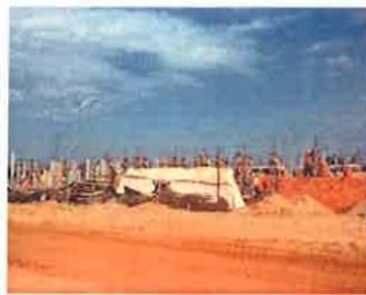
**Foto 05.** Acopio de materiales cerámicos. Para las paredes exteriores se utilizará ladrillo prensado visto, revocado al interior de la vivienda. Para las paredes interiores se utilizará ladrillo común procedente de Tobatí, revocado.
