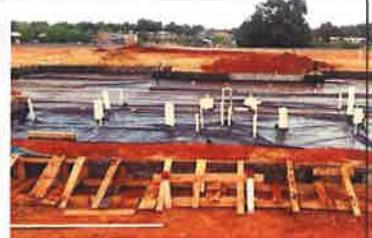
**Foto 03.** Finalizada la instalación sanitaria y eléctrica de una de las plateas. Se realizó una prueba hidráulica, la instalación debe ser totalmente estanca.
