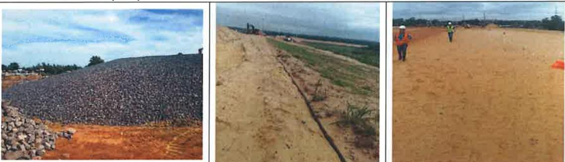
**Foto 01.** Taludes con protección de enrocado, ejecutado con colchones Reno, terminados
