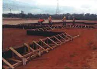
**Foto 02.** Demarcación y encofrado de platea de las viviendas, se construirán dos viviendas por platea
