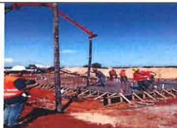
**Foto 02.** Proceso de vertido de la mezcla de hormigón en la losa de fundación, a la que previamente se le realizó la prueba hidráulica a la instalación sanitaria. Se consolida el hormigón con proceso de vibrado y se imprime superficialmente con un producto para el curado, a fin de evitar o minimizar fisuras.
