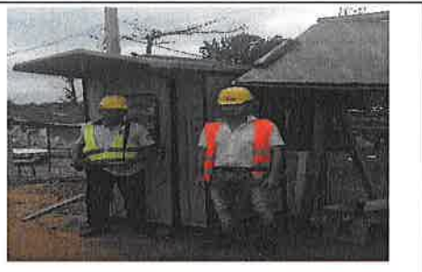
Imagen 3. Caseta de guardias con dos personales ubicada en la rampa de acceso a las viviendas, en el lindero entre la obra y el asentamiento
