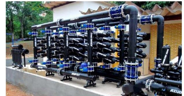
Se realizó la construcción de un sistema de Pre-Filtrado en la toma de agua cruda del Lago de la República en Ciudad del Este, con el fin de mejorar la calidad del agua potable a ser distribuida. Con esta mejora se beneficia a unas 48.000 personas con una inversión realizada de US\$ 500.000.
